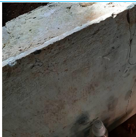
Matériaux : ZPSO-001 Prélèvement : P001; P002; P003; P004 Description : Enduits intérieurs - Murs intérieurs Localisation : Rez de chaussée - Habitation en ruine Résultat : Absence d'amiante
